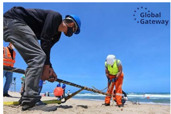
Arbeiter am Praia do Futuro, Brasilien, verlegen den letzten Abschnitt des 6000 km langen Glasfaserkabels EllaLink. Das Projekt ist Teil des BELLA-Programms und verbindet als Leuchtturmprojekt von Global Gateway Europa und Südamerika ©EllaLink Ireland Ltd
